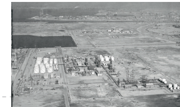
日産石油化学千葉工場(1968年頃)
